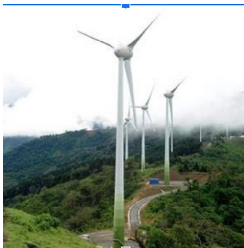
El complejo se compone de 17 aerogeneradores de 900 Kw cada uno, situados en los cerros de Tacacorí y Pacacua (Santa Ana) | ALBERT MARÍN.
